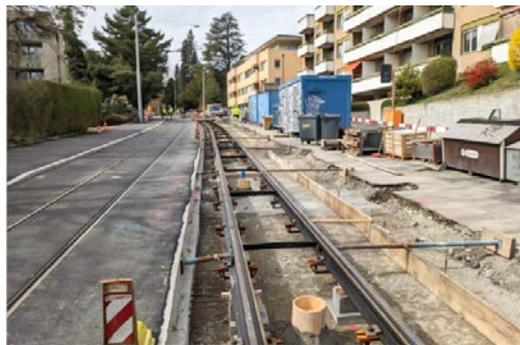
Im Zuge der umfangreichen Bauarbeiten in der Hönegger- und Limmattalstrasse wurden auch die Tramgleise und -fahrleitungen erneuert. (Bild: Katja Jauch, Locher Ingenieure AG)
