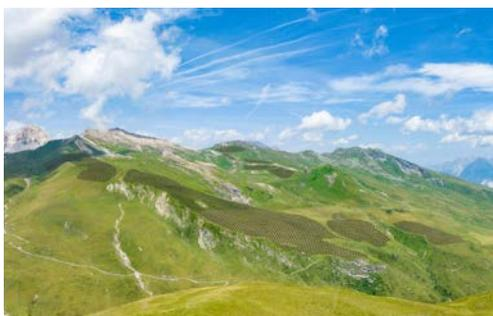
Nandro-Solar: Auf mehreren Flächen angrenzend an das Skigebiet Savognin sollen 93 000 Solarmodule jährlich bis zu 68 GWh Sonnenstrom produzieren. (Visualisierung: Fanzun AG/ewz)
