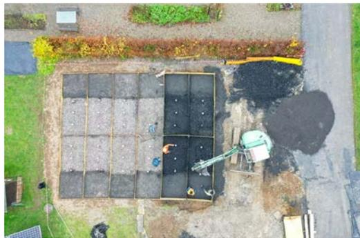
Auf dem Campus im Grüental wird das neue überbaubare Baumsubstrat für den Einsatz im urbanen Raum in einem Feldversuch getestet. (Bild: FG Pflanzenverwendung/ZHAW)
