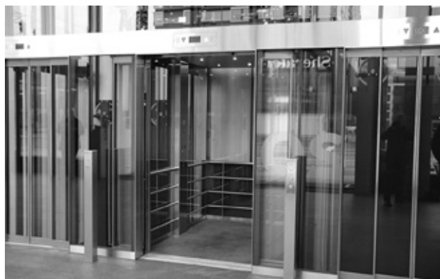
Zugang zu Aufzügen. (Bild: Gilbert Gullini)
