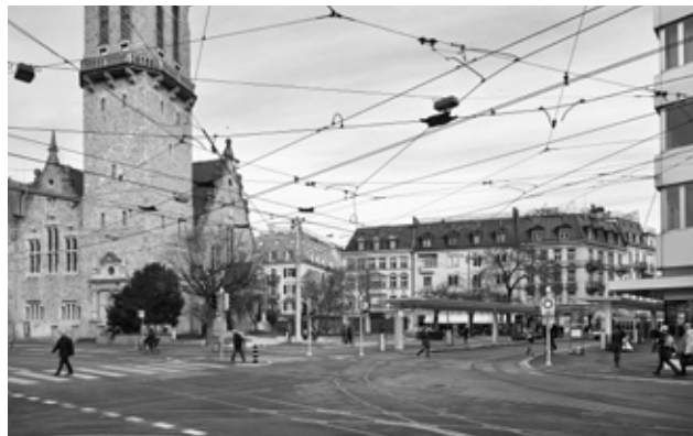
Die neue Kreuzung Badener-/Stauffacherstrasse mit Haltestelle und Kirchenvorplatz im Dezember 2017. (Bild: Hannes Henz Architektur fotograf)
