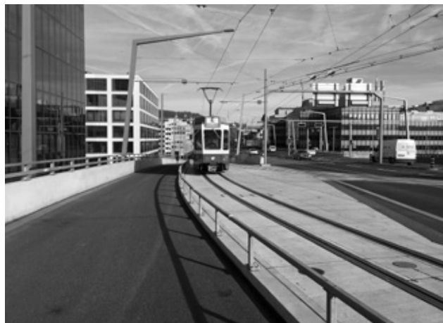
Tramverbindung Hardbrücke: Testfahrt auf der neuen Pfingstweidrampe. (Bild: Samuel Wüst, TAZ)
