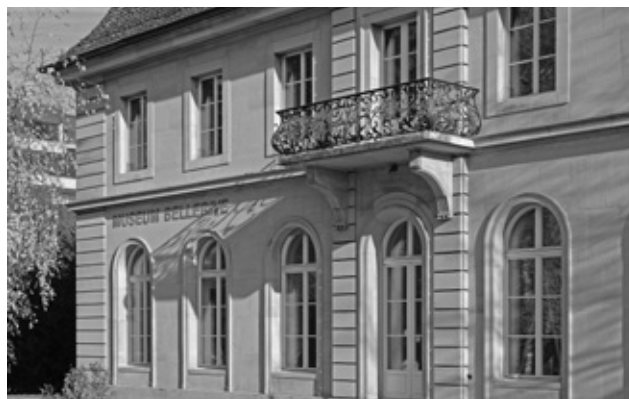
Das teilweise instand gesetzte Haus Bellerive vor Aufnahme des Pilotbetriebs zum Zürcher Architekturzentrum. (Bild: Marc Huber)
