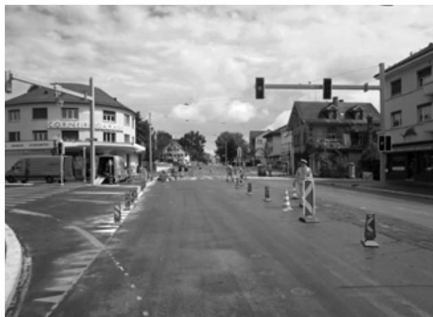
Schaffhauserstrasse bei der Einmündung Glatttalstrasse mit neuen Strassenmarkierungen. (Bild: Daniel Conte, Ingenieurbüro SNZ)
