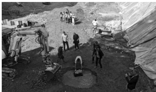
Neubau Schulhaus Schütze: Der Grundstein wird auf die Kassette gelegt. (Bild: Jacqueline Hehli, © KSP Limmattal)
