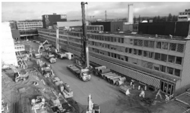
Baustelle beim Fernsehstudio Leutschenbach. (Bild: GeoZ)
