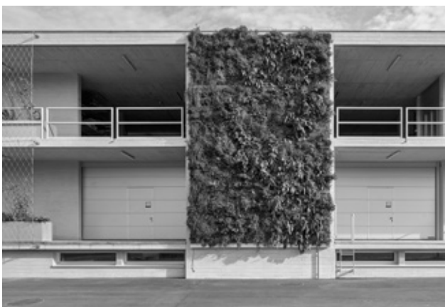
Fassadengrün: eines der Testfelder am Lagergebäude in der Stadtgärtnerei. (Bild: Johannes Marburg)
