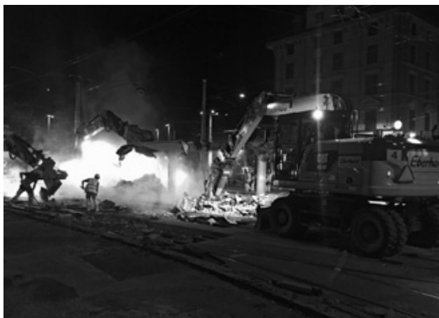
Gleisschlagwochenende, Abbruch des alten Wartedachs. (Bild: Ralph Jud, TAZ)
