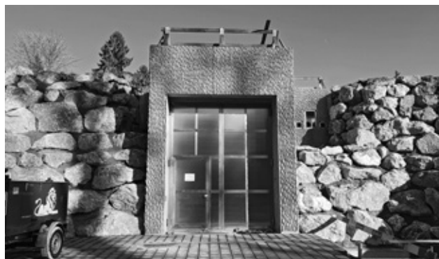
Neubau des Reservoirs Käferberg. (Bild: Wasserversorgung)
