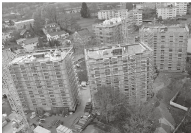
Blick auf die im Bau befindliche städtische Wohnsiedlung Rautistrasse. (Bild: Roger Spiegel)
