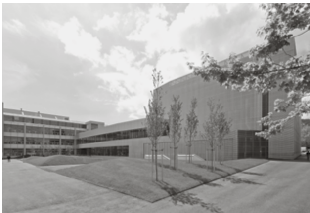
Der neue OIZ-Hauptsitz am Standort Albisrieden mit rund 400 Arbeitsplätzen und dem Rechenzentrum Albis. (Bild: Organisation und Informatik)
