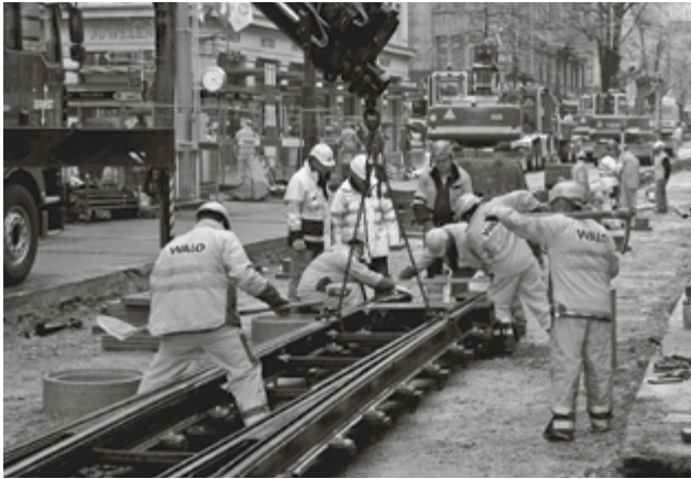
Gleiserneuerung in der Bahnhofstrasse. (Bild: VBZ)
