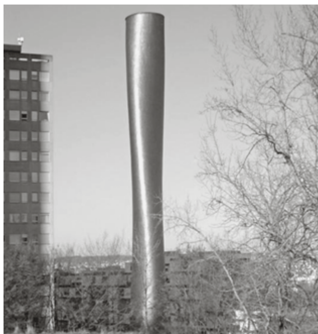
Sichtbares Zeichen: der 46 m hohe Kamin. (Bild: STZ)
