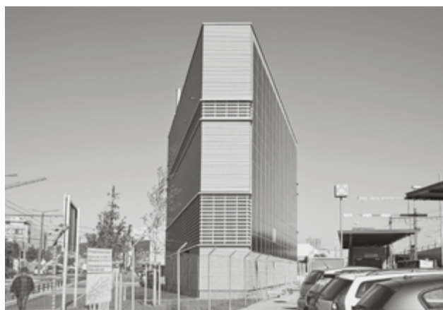
ewz-Energiezentrale an der Aargauerstrasse. (Bild: ewz)
