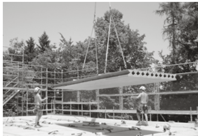
Beim Erweiterungsbau des Werkhofs Albisgütli wurden vorgefertigte Boden-Decken-Elemente in Triasol-Technik verwendet. (Bild: GSZ)
