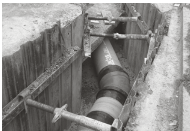
Baustelle: Rohrleitung, Durchmesser 600 mm, duktiler Guss mit Zementmörtelumhüllung. (Bild: Wasserversorgung)
