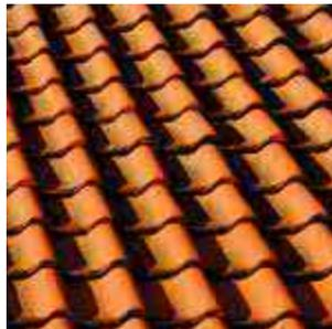
Abb. 139: Albedowert Dachziegel 0,1–0,35
