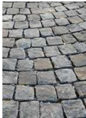
Abb. 103: Pflasterung mit offenen, nicht zementierten Fugen
