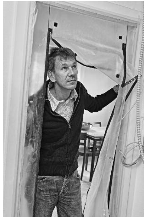
SCHMUTZSCHLEUSE GEGEN DEN UMBAUSTAUB
