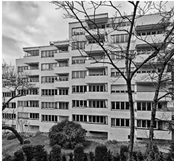
ERNEUERTE FASSADE AN DER HEGIBACHSTRASSE 54, 56 UND 58
