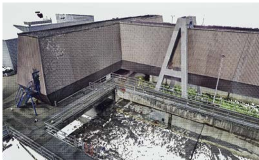
Punktwolke der Bestandsaufnahme im Pilotabschnitt des Hochkanals Werdhölzli (Bild: GeoZ)
