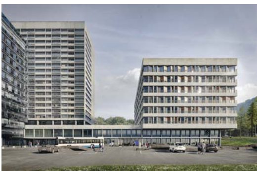
Das Rehazentrum Triemli Zürich (rechts) soll 2025 seine Türen öffnen. (Bild: Kliniken Valens)
