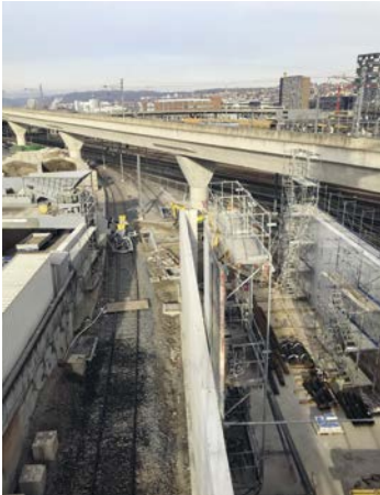
Baustellenübersicht (Bild: GeoZ)
