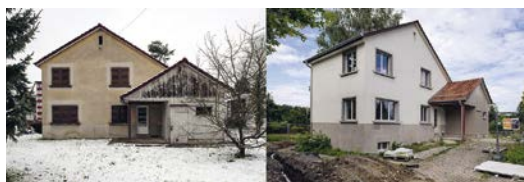
Ein Wohnhaus der Siedlung Au vor und nach der Instandsetzung. (Bild: Juliet Haller)
