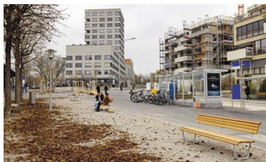
Der Vorplatz des Bahnhofs Binz wurde grosszügiger und rollstuhlgängig gestaltet. Den Baumbestand hat das Tiefbauamt um fünfzehn zusätzliche Bäume ergänzt. (Bild: TAZ)
