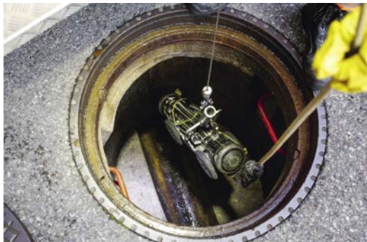
Für die Inspektionen von Kanälen, die weniger als 1,25 m hoch sind, werden Kamera-Roboter eingesetzt. (Bild: ERZ)
