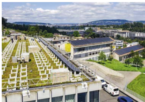
Die PV-Anlage auf dem Schulhaus Falletsche aus dem Solar-Beteiligungsmodell ewz.solarzüri wurde im Sommer 2021 erstellt. Sie umfasst rund 1100 m 2 Fläche, verfügt über eine Leistung von 148 kWp und soll künftig 88 000 kWh Sonnenstrom pro Jahr produzieren. (Bild: 20min/Michael Scherrer)
