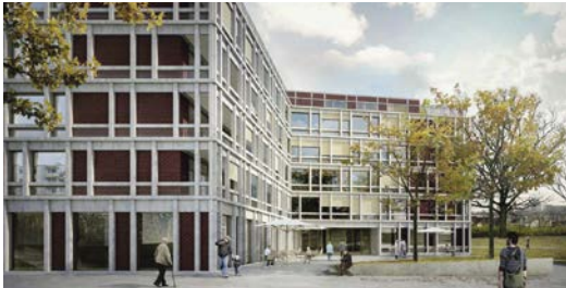
Ersatzneubau Gesundheitszentrum für das Alter Mathysweg. Bezug ab Sommer 2022. (Bild: Allemann Bauer Eigenmann Architekten, Zürich)
