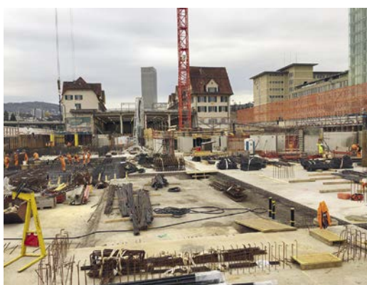
Baustelle Tramdepot und Wohnsiedlung Depot Hard mit dem bestehenden Depotteil im Hintergrund. Stand Oktober 2021. (Bild: Caretta Weidmann, Zürich)
