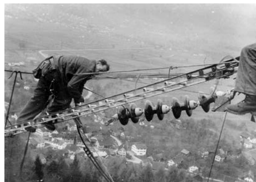
Montage von 150-kV-Abspannketten und Stromschlaufen (1950). (Bild: ewz-Bildarchiv im Stadtarchiv Zürich)
