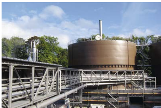
In den Gasometern wird das bei der Schlammbehandlung produzierte Klärgas zwischengespeichert, bevor es aufbereitet und ins Gasnetz eingespeist wird. (Bild: ERZ)
