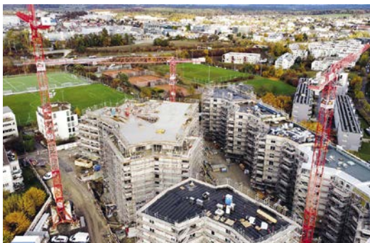
Die Überbauung Gesundheitszentrum für das Alter und kommunale Wohnsiedlung Eichrain in Zürich-Seebach. Baustelle, Stand November 2021. (Bild: b+p Baurealisation, Zürich)
