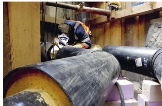
Um Kosten und Emissionen tief zu halten, erfolgt die Verlegung von Fernwärme-Leitungen wenn immer möglich in Koordination mit anderen Strassenbau- und Werkleitungsprojekten. (Bild: ERZ)
