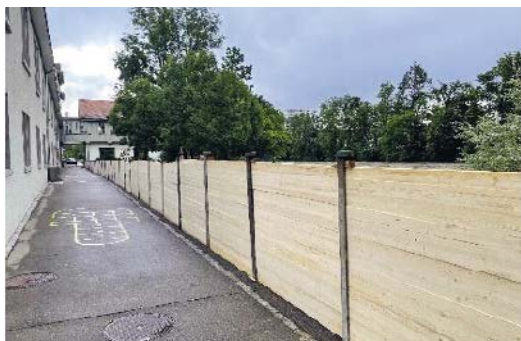
Hochwasserschutz für die Schulanlage Am Wasser. (Foto: Reto Disler)
