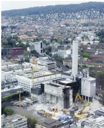
Der markante, rund 90 Meter hohe Kamin des Werks Josefstrasse wird weiterhin für die Energiezentrale benötigt und bleibt deshalb stehen. (Bild: ERZ)
