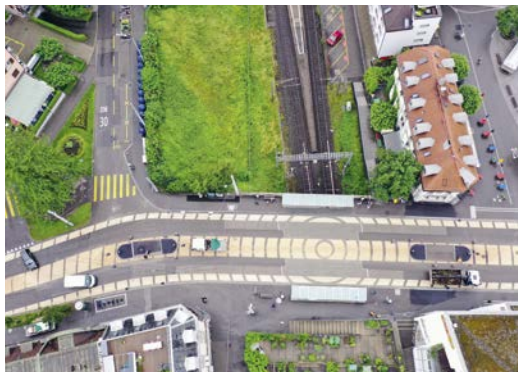
Der temporäre Mehrzweckstreifen an der Nordbrücke ist rund 3,5 m breit, 130 m lang und befindet sich in der Fahrbahnmitte der Nordstrasse, Abschnitt Lägern- bis Scheffelstrasse. (Bild: Albi Massalongo)
