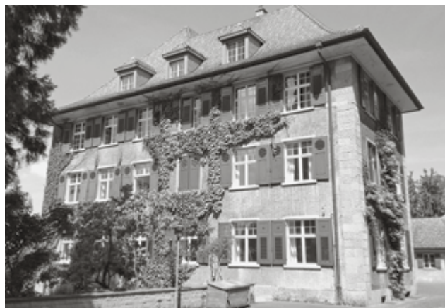
Haus Sonnenberg in Zürich-Hottingen. (Bild: Stadt Zürich)
