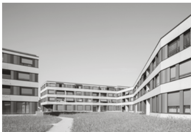
Die Siedlung Köschenrüti kurz nach der Eröffnung im Juli 2014. (Bild: Dominique Marc Wehrli)
