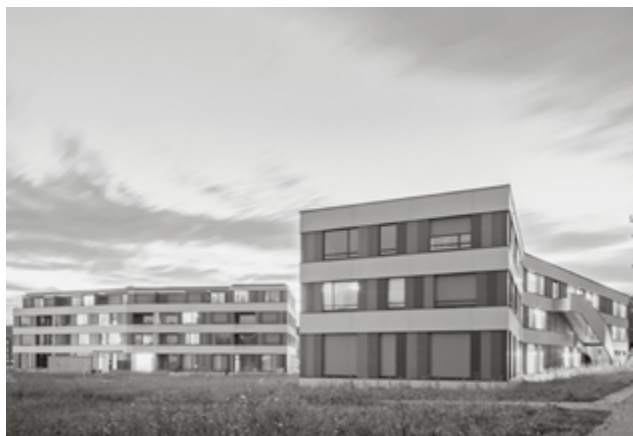
Alterswohnsiedlung Köschenrüti: am Stadtrand mit der Busstation vor der Haustür. (Bild: Dominique Marc Wehrli)
