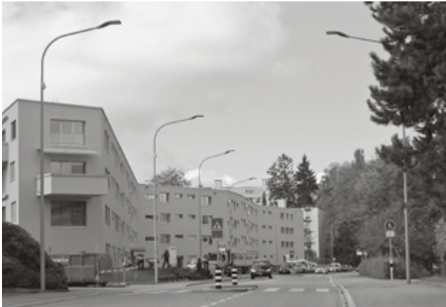
LED-Strassenbeleuchtung an der Furttalstrasse. (Bild: ewz)
