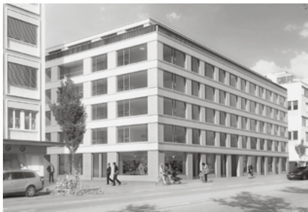
Anfang 2017 sollen die Bauarbeiten an der Erikastrasse starten. (Visualisierung: Zita Cotti Architekten AG, Zürich)
