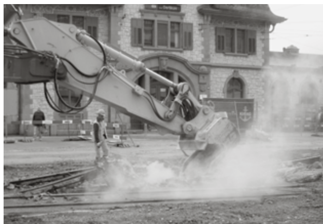
Gleiserneuerung am Bahnhof Oerlikon. (Bild: VBZ)
