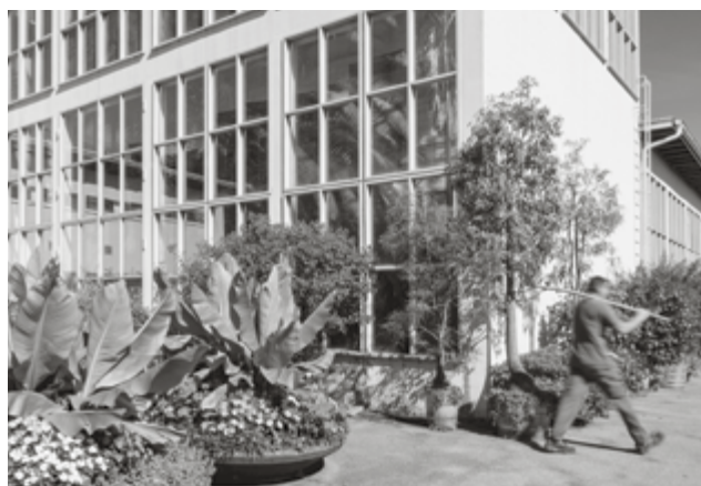
Im Berichtsjahr konnte unter anderem die Instandsetzung der Stadtgärtnerei abgeschlossen werden. (Foto: Balz Murer)
