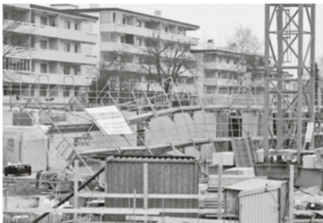
Umgestütztes Gerüst. (Bild: Marcel Gmür)
