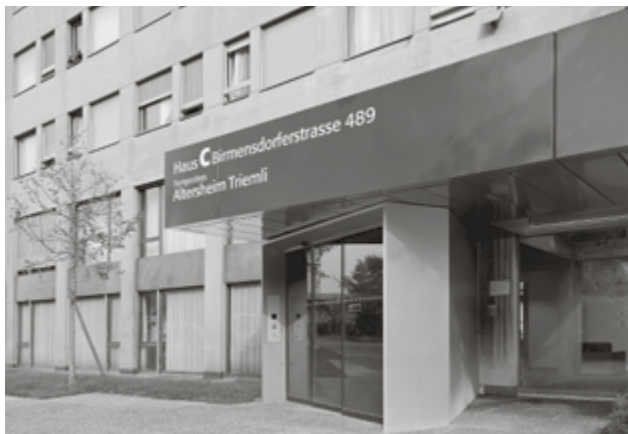
Zentrales Objekt der Rochadeplanung: Das temporäre Alterszentrum Triemli ermöglicht die Instandsetzung städtischer Alterszentren ausserhalb des Betriebs. (Foto: Ralph Feiner)
