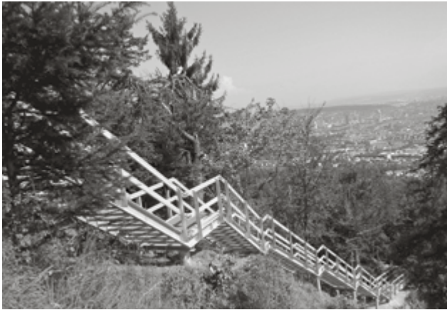
Der sanierte, auf dem Fels verankerte Föhreneggweg verläuft neu entlang der Geländekante. (Bild: GSZ)
