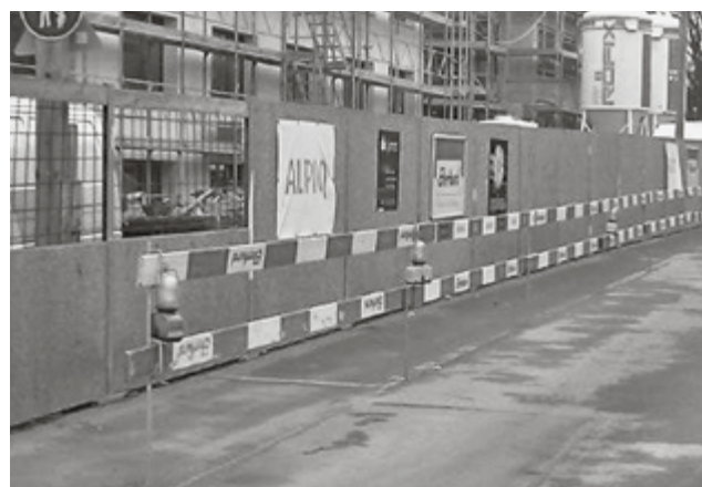
Bauwand mit Fussgängerführung. (Bild: Marcel Gmür)
