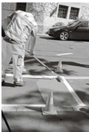
Anbringung einer roten Einfärbung in der Leonhardstrasse. (Bild: DAV)
