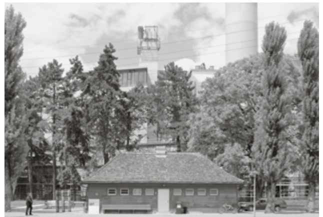
Kehricht-Heizkraftwerk Josefstrasse: Für die Zeit nach Stilllegung des Betriebs gilt es neue städtische Nutzungen des Areals zu koordinieren. (Bild: Marc Huber)
