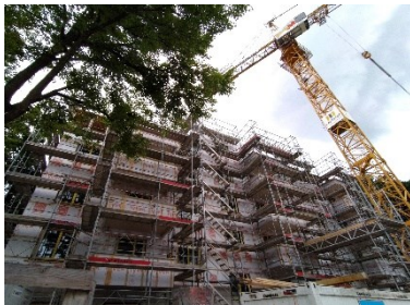
Im Juni 2025 war der Rohbau des Ersatzneubaus Espenhof West fertig. Bild: SAW
