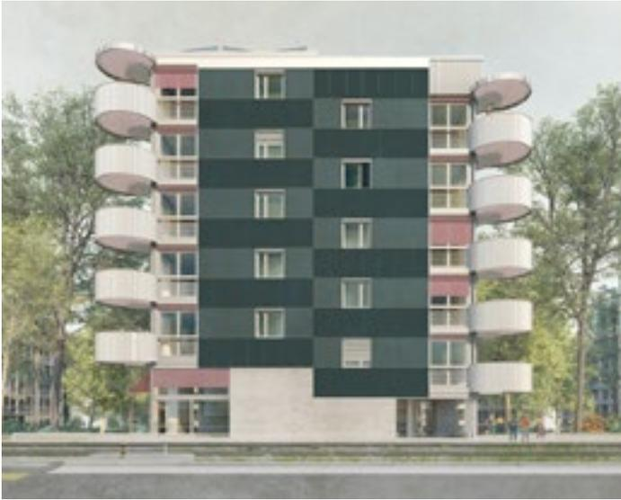
Die Stiftung plant auf dem Areal zwei Ersatzneubauten. Das Projekt knüpft mit einer Laubengangtypologie an die benachbarten Bauten an. Die Stirnfassaden der Gebäude sind mit Photovoltaik Paneelen belegt, die gleichzeitig die Fassade bilden. Das Bauprojekt mit Kostenvoranschlag wurde im Oktober 2024 verabschiedet, die Baueingabe erfolgte per Ende Jahr. Der Baubeginn ist für Herbst 2025 vorgesehen, die Fertigstellung bis 2028 geplant.
