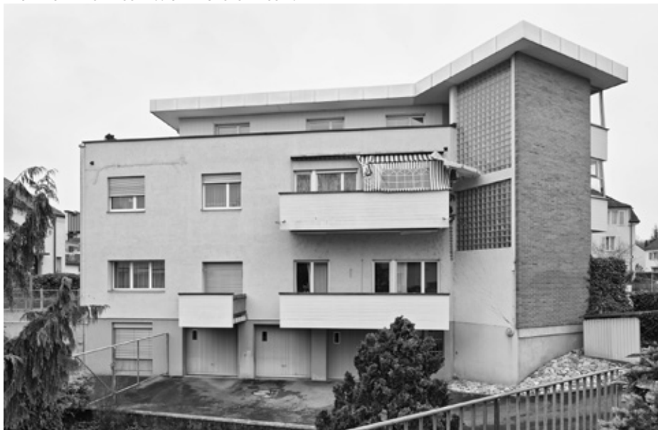
NEUNBRUNNENSTRASSE 259 UND HÜRSTSTRASSE 64
