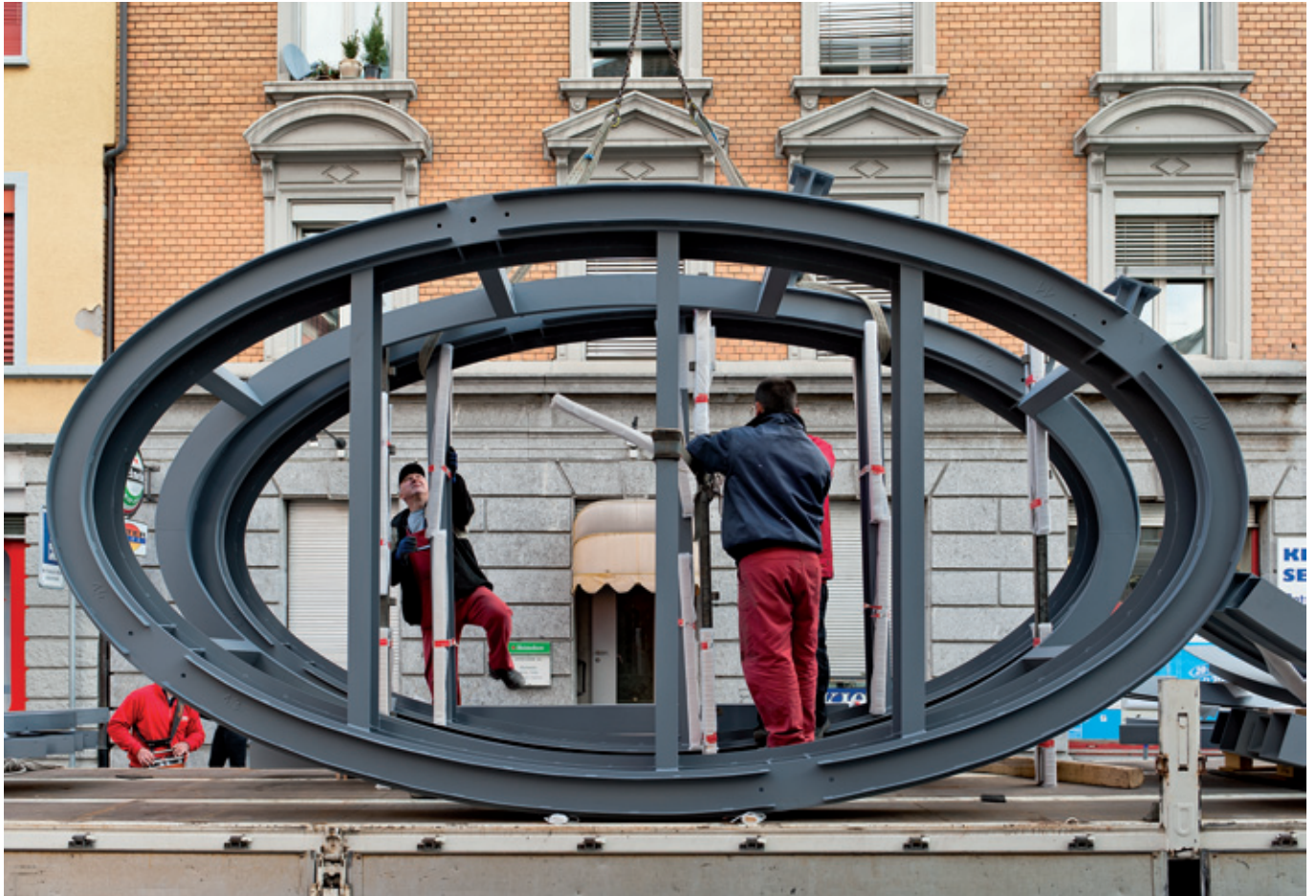
DER BALKONTURM AN DER HOHLSTRASSE 9 WURDE IN DER WERKSTATT VORGEFERTIGT, EIN KRAN HIEVTE DIE STAHLRAHMEN AN IHREN ORT.
